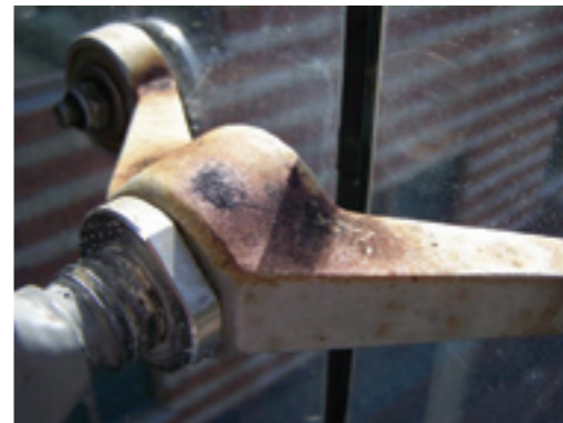
Afbeelding 3. Door aerosolen zwaar aangetast roestvaststalen gietwerk
