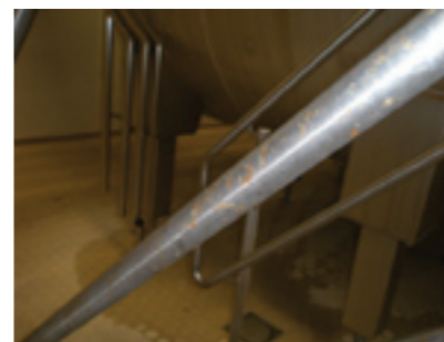
Afbeelding 5. (links) Een aangetaste leuning van RVS 304 in een kaasfabriek.
