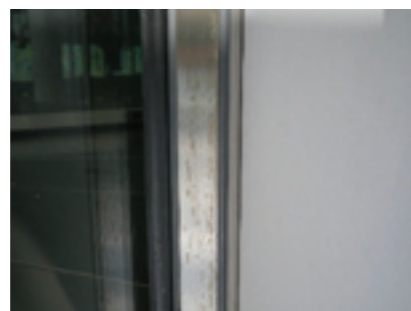
Afbeelding 7. (links) Zogenaamde theevlekken door aerosolen op een roestvaststalen 'glaslat'.
